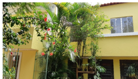
Depois da reforma...
